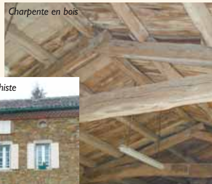
Charpente en bois
