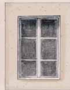
Ouverture récente avec encadrement souligné par la finition de l'enduit
