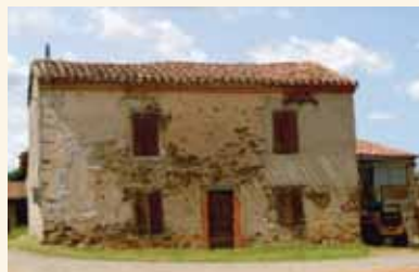
Toiture en tuile canal
