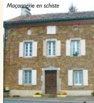
Maçonnerie en schiste
