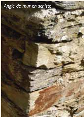
Maçonnerie en schiste et granit
