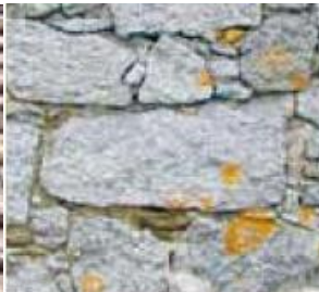
Mur en granit
